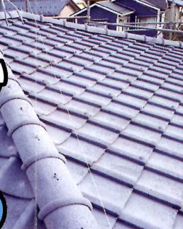
【下塗り施工後】
