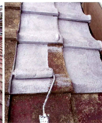
【下塗り施工中】
