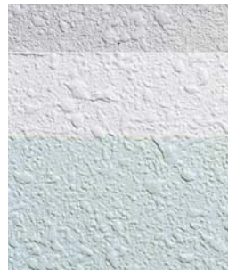
薄付け仕上げ (下地のパターンを生かす)
