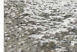
写真1 骨材散布量の目安
